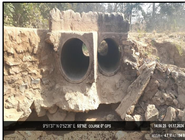
Photo 15 : 2 buses Ø800 Tronçon : Kadjalim – Tchomé Nakoko
