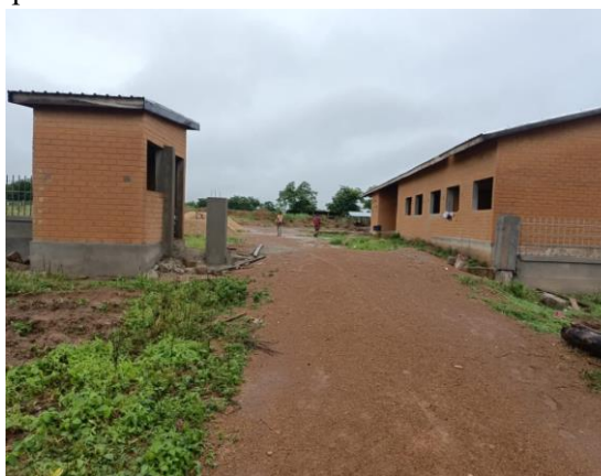
Infrastructures bordant la piste rurale
