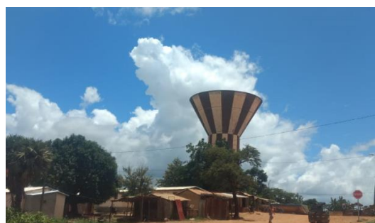
D. Château d'eau
